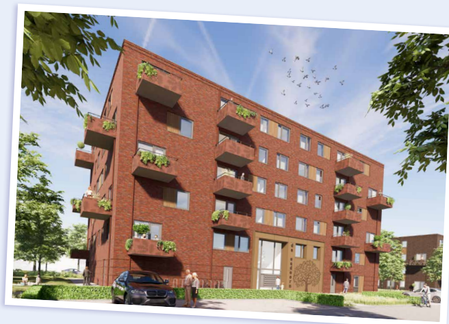
De entree van de esdoorn aan de zijde van het Handelscentrum
